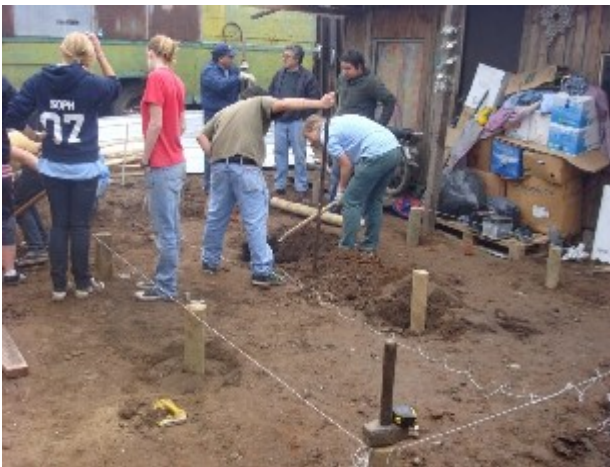
Hausbau in Baracken-Siedlung
